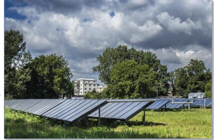
Fernheizwerk Graz (FHW) Source: Picfly.at Thomas Eberhard
