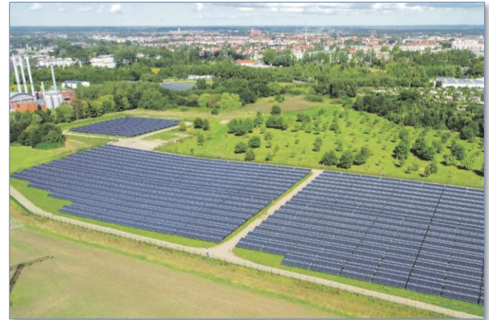
Stadtwerke Greifswald Source: Ritter XL Solar
